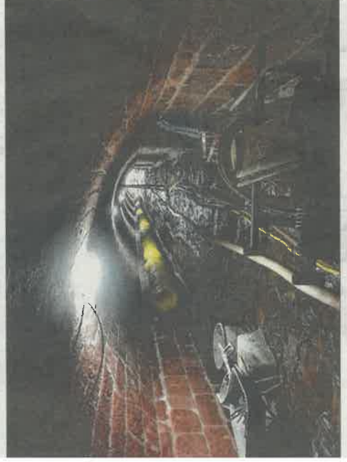
Das Gewölbe unterhalb der B 28 in Bad Griesbach, in dem der Irtlesbach fließt, wird saniert. Archivfoto: Guidenschulh/RP
